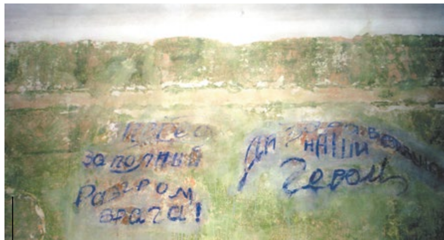
Napis pozostawiony przez żołnierza radzieckiego w jednym z pomieszczeń budynku sądu przy ul. Powstańców Warszawy, odkryty w czasie remontu
