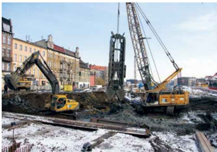
Przeście dla pieszych na ul. Zwycięstwa prowadzi przez teren budowy – innego wyjścia nie było
