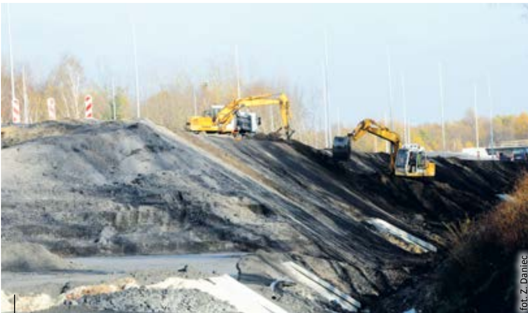
Na G1 ponad 50% nasypów pod przyszłą drogą jest już gotowych
