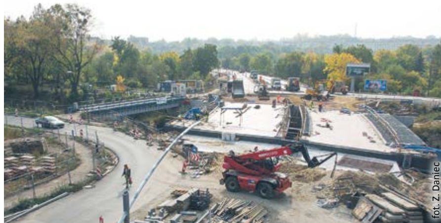
Trwają końcowe roboty przy węźle DTŚ z ul. Jana Śliwki i przygotowania do otwarcia docelowego przejazdu nowym mostem nad Kłodnicą i przebudowanymi fragmentami ulic Jana Śliwki oraz Orlickiego. Jak zawiadamia Eurovia Polska S.A., do 30 października niemożliwy będzie wjazd z ul. Wybrzeże Armii Krajowej w ul. Jana Śliwki
