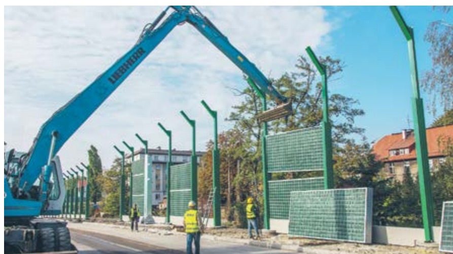
Przy trasie budowane są ekrany akustyczne
