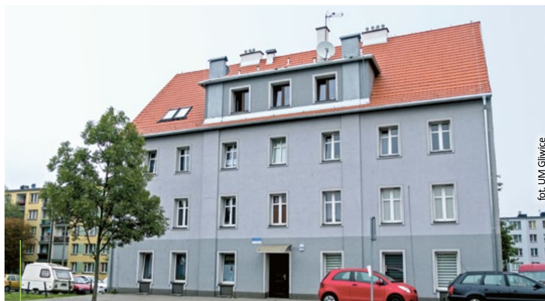
Budynek przy ul. Kozielskiej 56 to jedna z lokalizacji, w których trwa podłączanie do miejskiej sieci ciepłowniczej. Takich inwestycji jest w mieście coraz więcej
