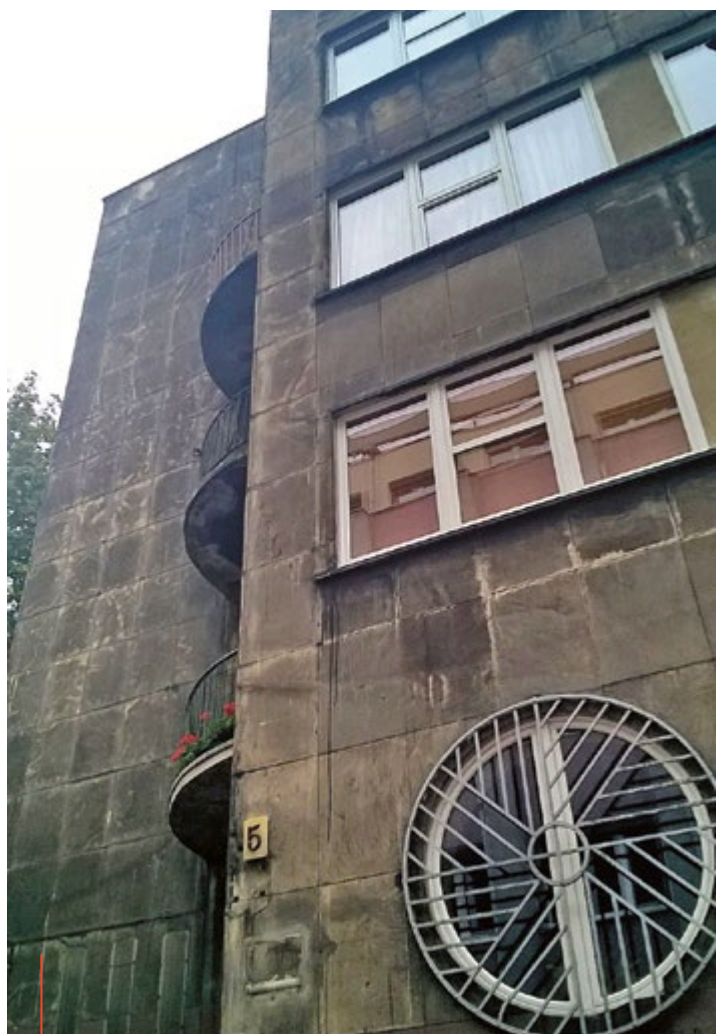
Katowice, ul. Kobylińskiego 5 – zachowany fragment gmachu Muzeum Śląskiego, część mieszkalna autorstwa K. Schayera
