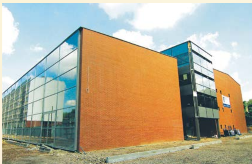
Budowa siedziby naszej gliwickiej, technologicznej peretki – TECHNOPARKU już prawie ukończona (zdjęcie z sierpnia)
