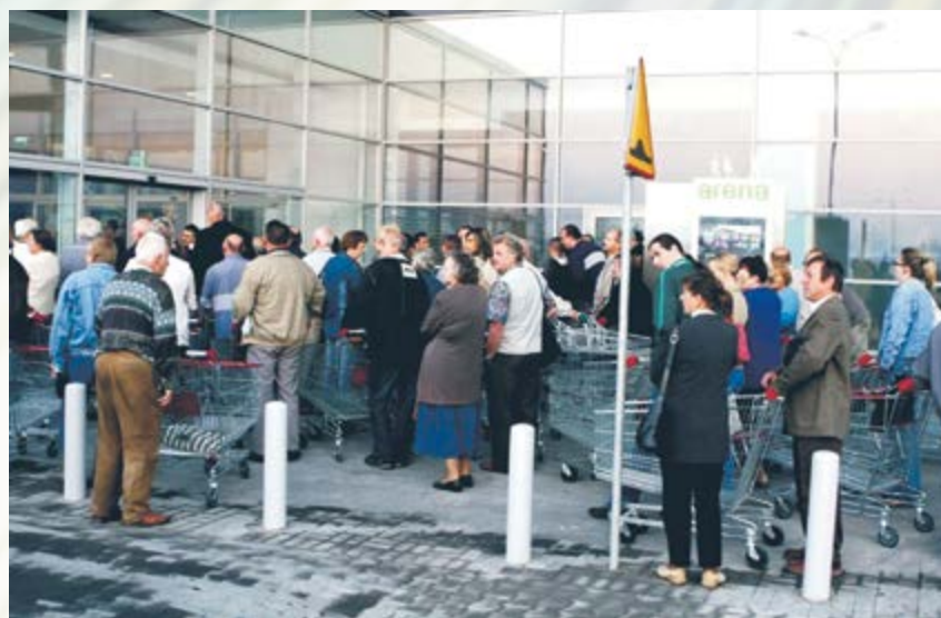
Pod koniec września przekazano do użytku nowy kompleks handlowy – ARENA
