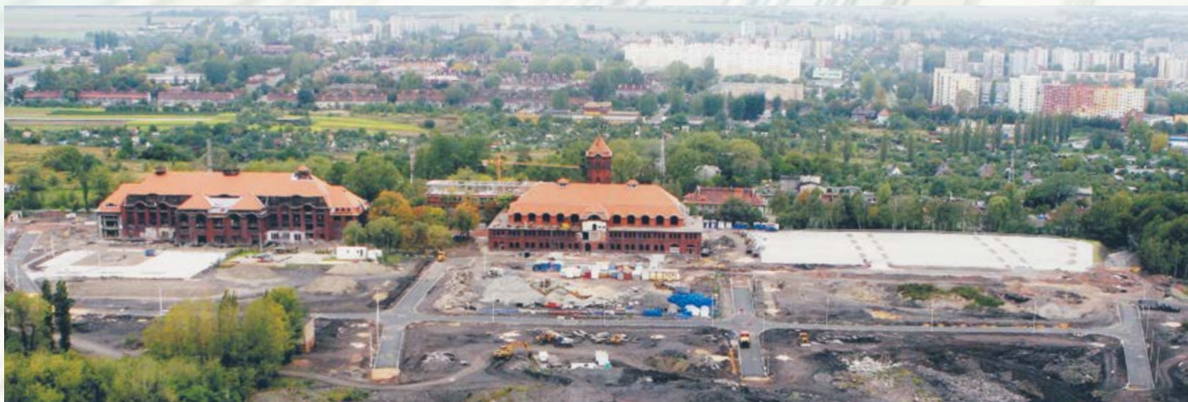
Budowa „Nowych Gliwic” – zdjęcie z października 2006 roku
