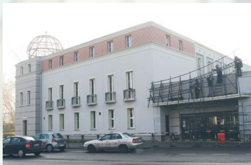
Odnowiona elewacja Gliwickiego Teatru Muzycznego. Budynek przeszedł termomodernizację
