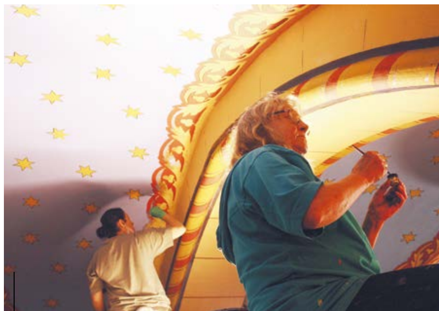
Prace renowacyjne wykonywane są z precyzją i starannością
