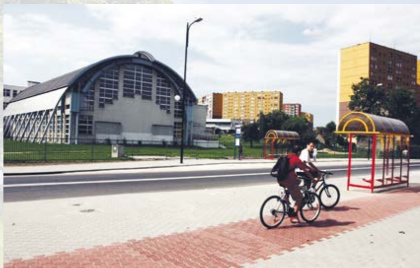
Zakończono przebudowę dwukilometrowego odcinka ul. Kozielskiej – od ul. Daszyńskiego do ronda usytuowanego u zbiegu z ul. Łąbedzką
