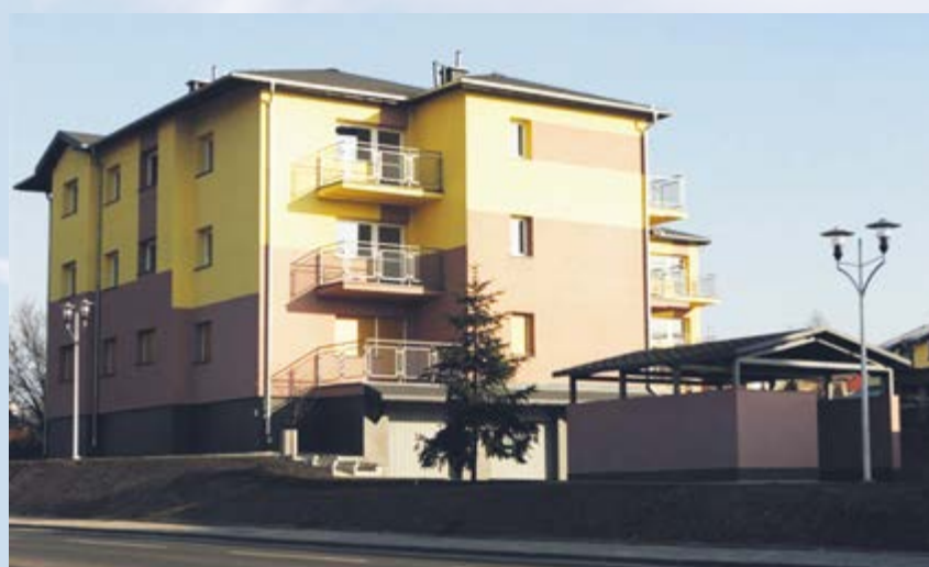
Przekazano do użytku kolejny dom powstały w ramach TBS. Obiekt przy ul. Bernardyńskiej 50-52 został zrealizowany przez ZBM II TBS
