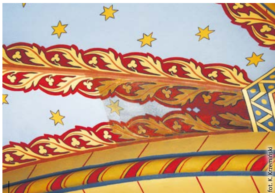
„Świadek Historii” – zachowane oryginalne fragmenty sklepienia, nienaruszone w trakcie modernizacji, będą widoczne w trzech punktach odnowionej polichromii (na zdj. widoczny jako ciemniejszy fragment)
