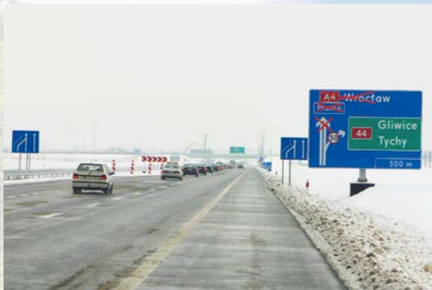
Oddano do eksploatacji prawie 16-kilometrowy fragment autostrady A4 od węzła Batory w Chorzowie, do węzła Sośnica w Gliwicach
