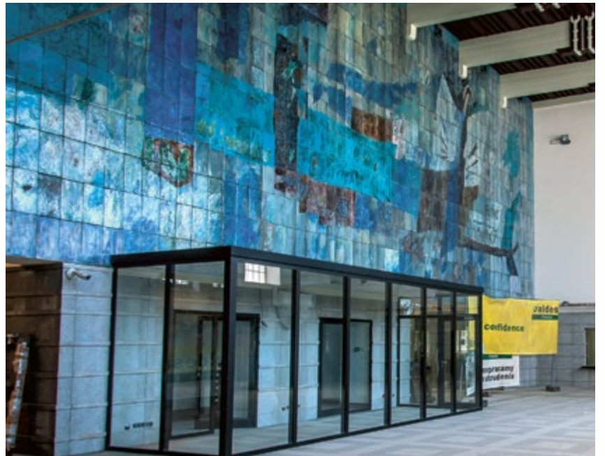
DWORZEC KOLEJOWY. Trwają prace wykończeniowe. Charakterystyczna mozaika w holu głównym została zachowana. (fot. Z. Daniec)
