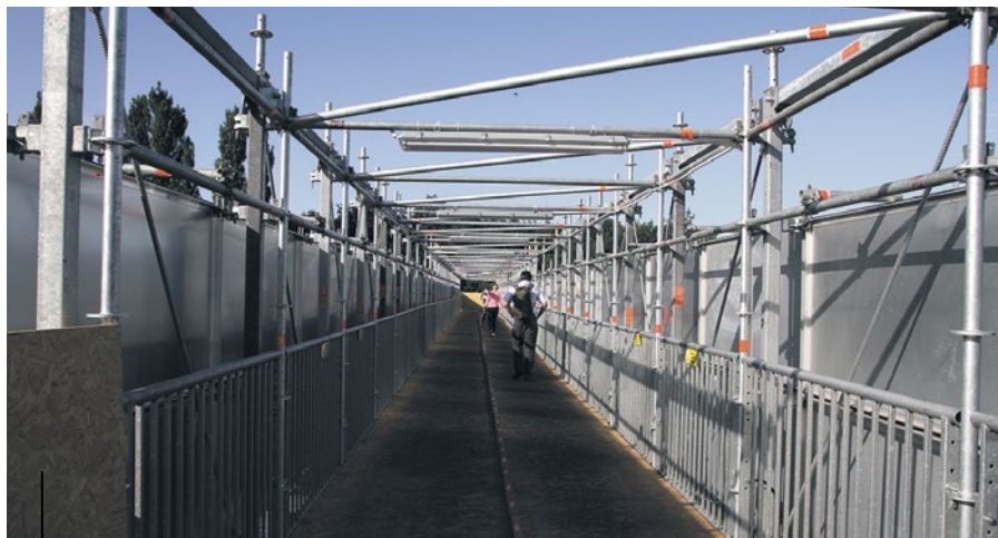
Pomiędzy czynnymi peronami nr 1 i 4 podróżni przemieszczają się kładką nad placem budowy
