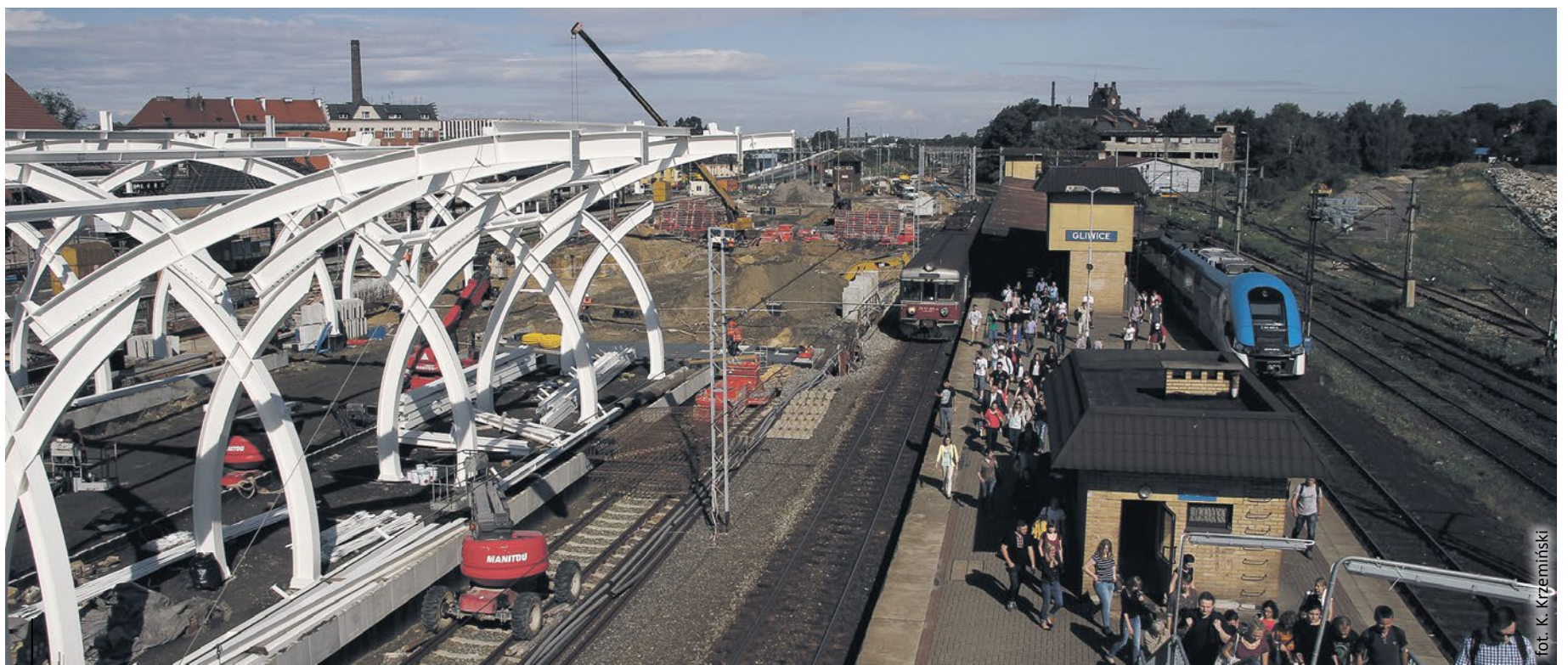
Stacja Gliwice to obecnie wielki plac budowy. Mimo to ruch pasażerski obsługiwany jest na bieżąco
