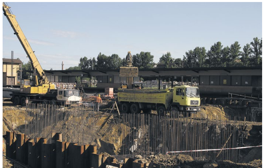
Trwa budowa peronów nr 2 i 3 oraz odbudowa przejść pod torami kolejowymi
