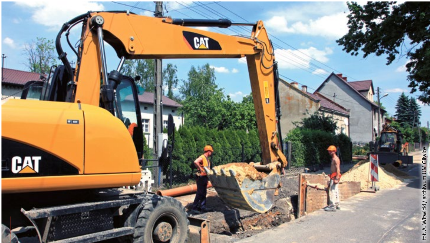
Zdobycie unijnej dotacji w wysokości 162 mln zł pozwoliło PWiK w Gliwicach rozbudować i zmodernizować w latach 2007–2013 miejską sieć wodno-ściekową. Inwestycja miejskiej spółki miała znaczący wpływ na poprawę stanu środowiska w dorzeczu rzeki Kłodnicy, a co za tym idzie – na poprawę czystości wód Odry.
