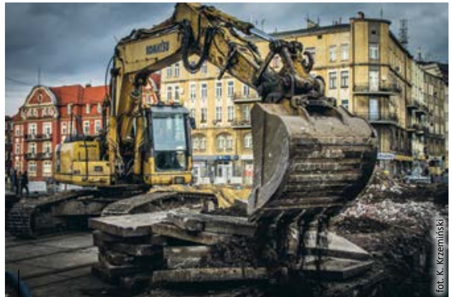
Budowa Drogowej Trasy Średnicowej – odcinek G2
