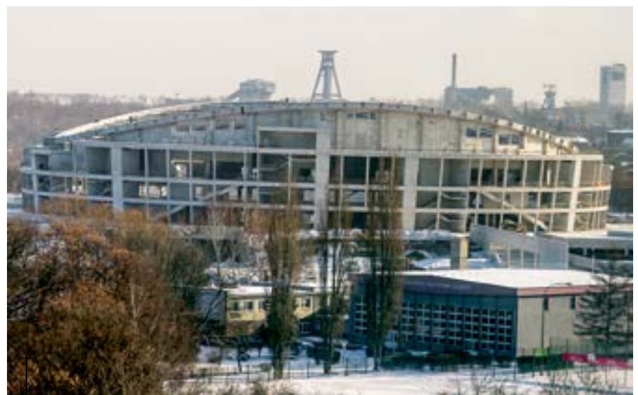
Hala widowiskowo-sportowa GLIWICE
