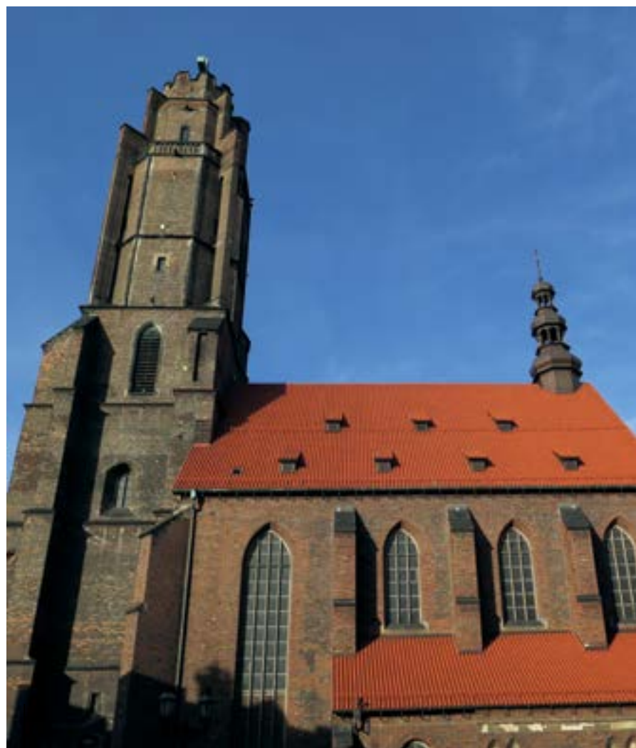
Dach kościoła pw. Wszystkich Świętych po remoncie w 2009 r.
