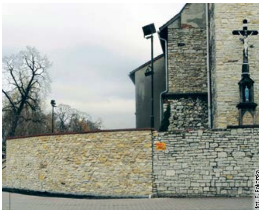
Mur oporowy kościółka pw. św. Bartłomieja po naprawie
