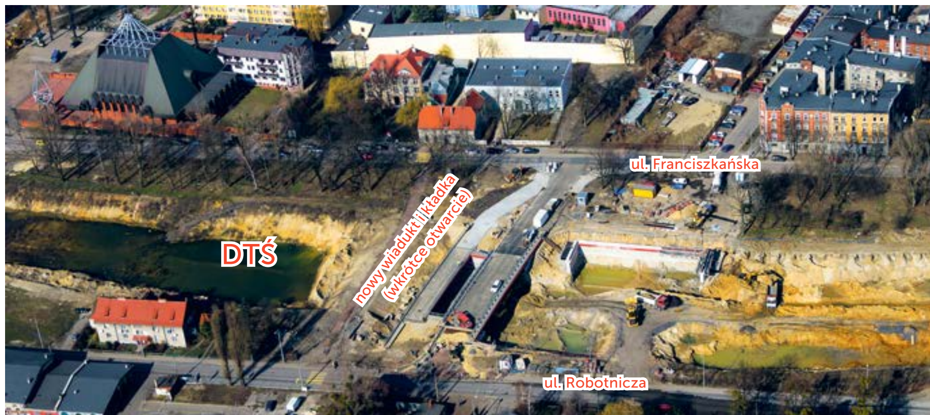
W tunelu pod ulicami Zwycięstwa i Dworcową zabetonowano 70% stropów i kontynuowane są wykopy
