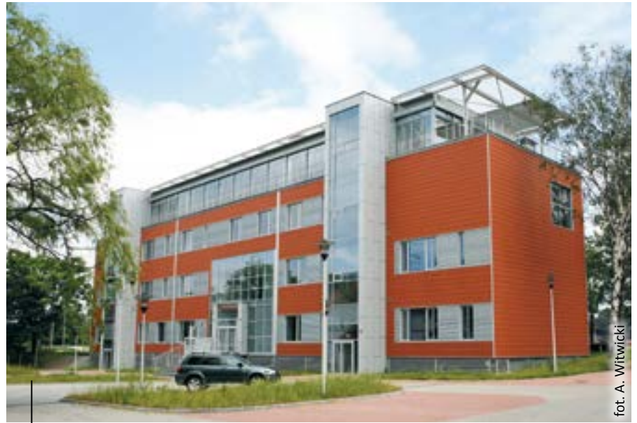
Na wynajęcie całego budynku biurowego o powierzchni 2600 m 2 zdecydowała się jedna z firm branży informatycznej
