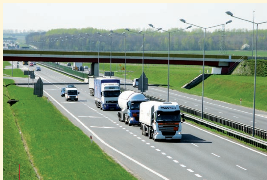
Aby ułatwić mieszkańcom dostęp do autostradowej obwodnicy, na A4 powstały cztery węzły
