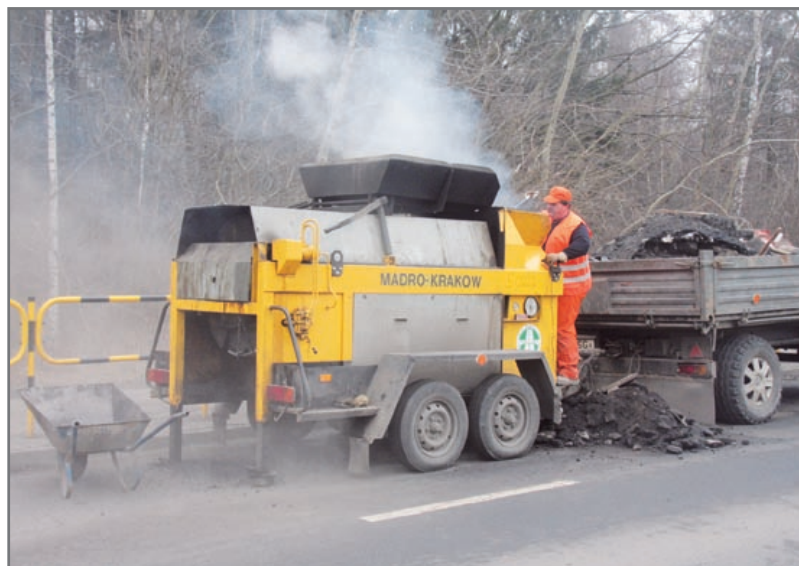
Gruntowny remont w obrębie ul. Oriona
