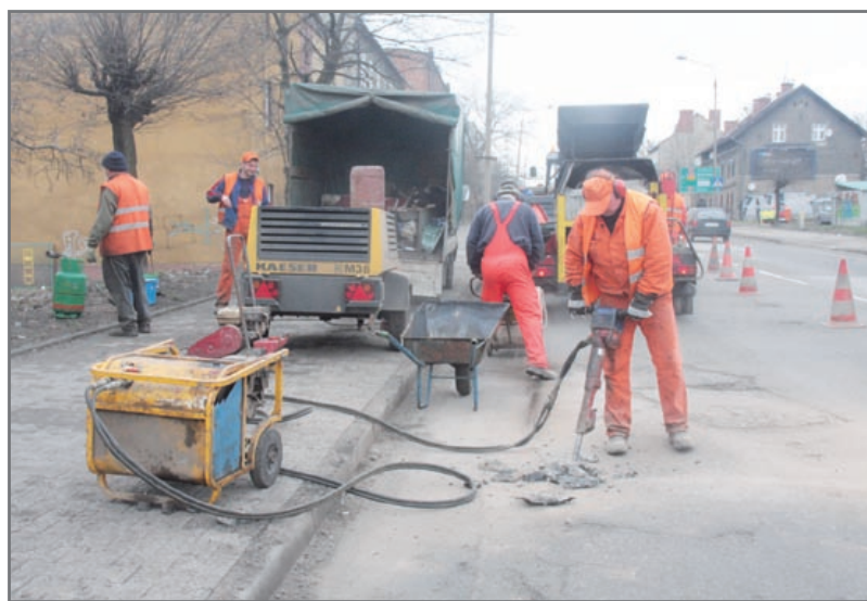
Przygotowania do wymiany fragmentu nawierzchni ul. Toszeckiej
