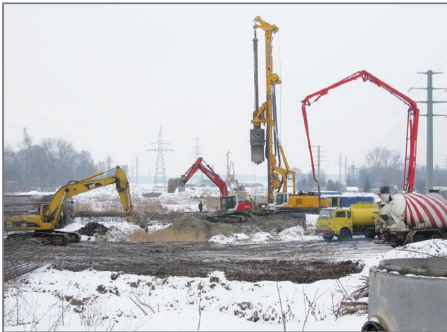
Budowa odcinka „Sośnica – Maciejów” na autostradzie A1 przebiega bez przeszkód – zakończenie prac przewidziano na połowę 2011 roku
