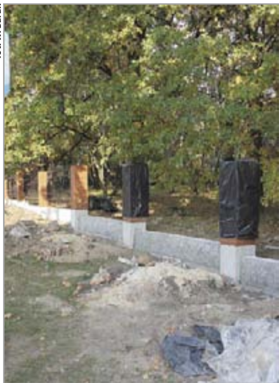
Budowa nowego ogrodzenia cmentarnego przy ul. Wrzosowej w Łabędach
