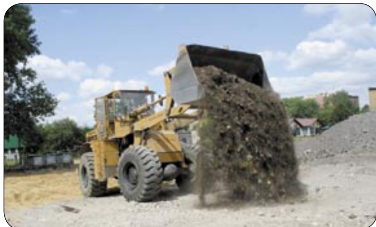
W Sońnicy przy ul. Przedwiośnie 2 powstaje nowe boisko szkolne
