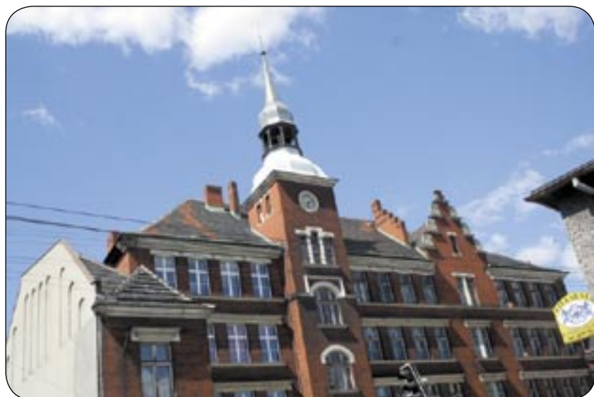
Wyremontowany budynek Szkoły Podstawowej nr 20 przy ul. Jana Śliwki 8
