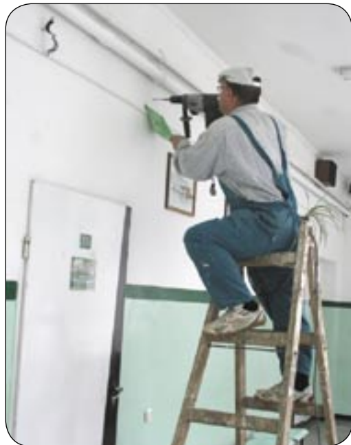
Montaż instalacji wodnej w budynku Zespołu Szkół Ponadgimnazjalnych (ul. Jasna 31)
