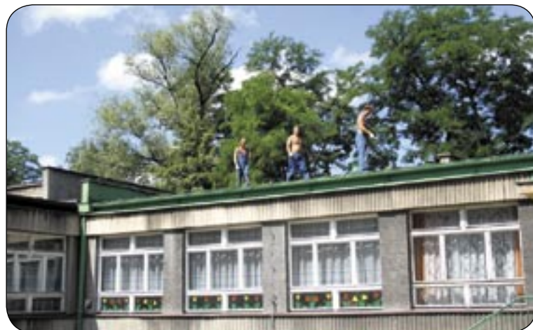
A w SP nr 36 (ul. Robotnicza 6) trwa remont dachu ...
