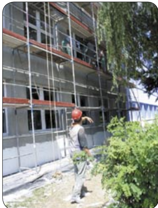
Prace termomodernizacyjne budynku Zespołu Szkół Łączności (ul. Warszawska 35) w pełnym toku
