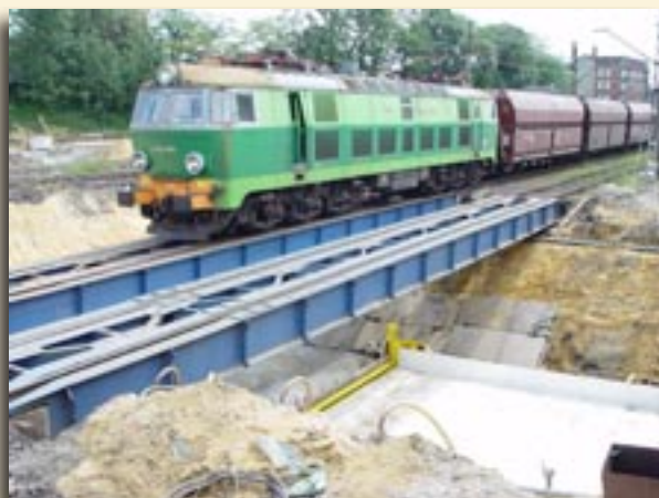
Dla potrzeb inwestycji zbudowano dwie konstrukcje mostowe, po których poruszają się pociągi
