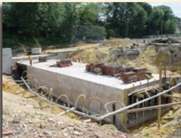
Jeden z siedmiu segmentów przyszłego przejścia podziemnego
