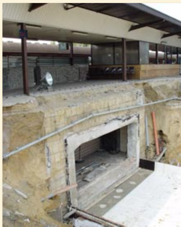
Pod czwartym peronem wykuto już otwór
