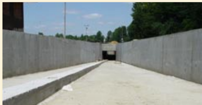
Pochylnia zapewni niepełnosprawnym łatwy dostęp do budynku dworca PKP
