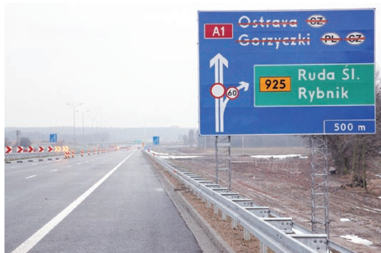
Zjazdy przy końcu odcinka autostrady A1 w Bełku
