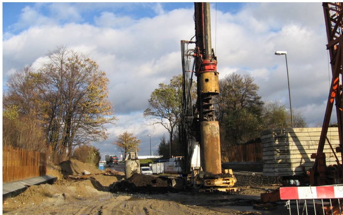
Wiercenie pala – roboty przy budowie nowego mostu nad ul. Wyczółkowskiego (grudzień 2006)
