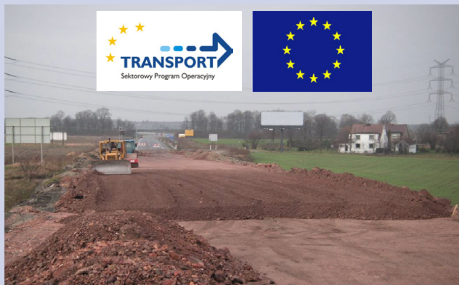
Budowa nasypu w ciągu DK 88 (grudzień 2006)
