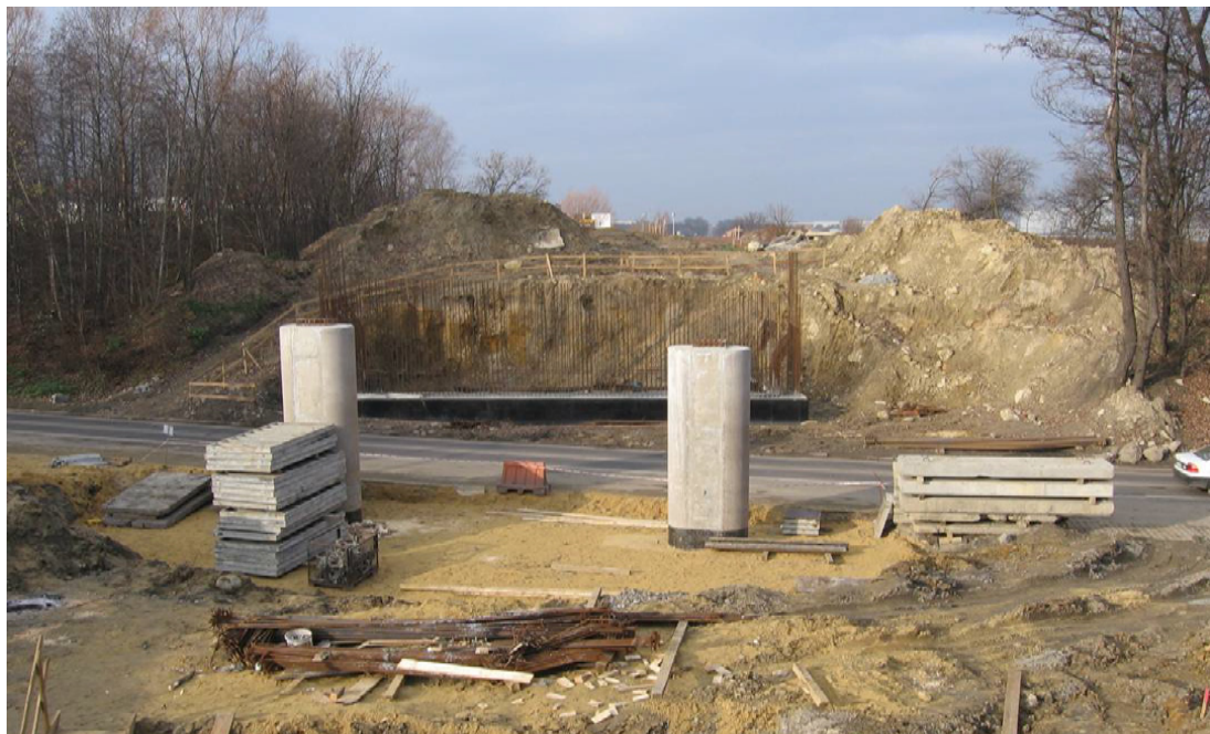
Roboty mostowe – wiadukt nad ul. Edisona (grudzień 2006)
