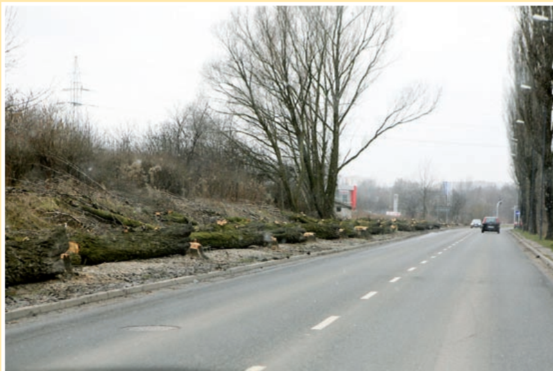
„Jedynka” skrzyżuje się w Gliwicach z Drogą Krajową nr 88 – powstanie węzeł „Maciejów”
