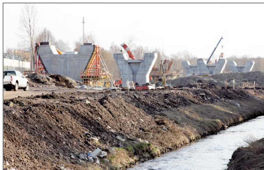
Prace są prowadzone m.in. w sąsiedztwie rzeki Bytomki
