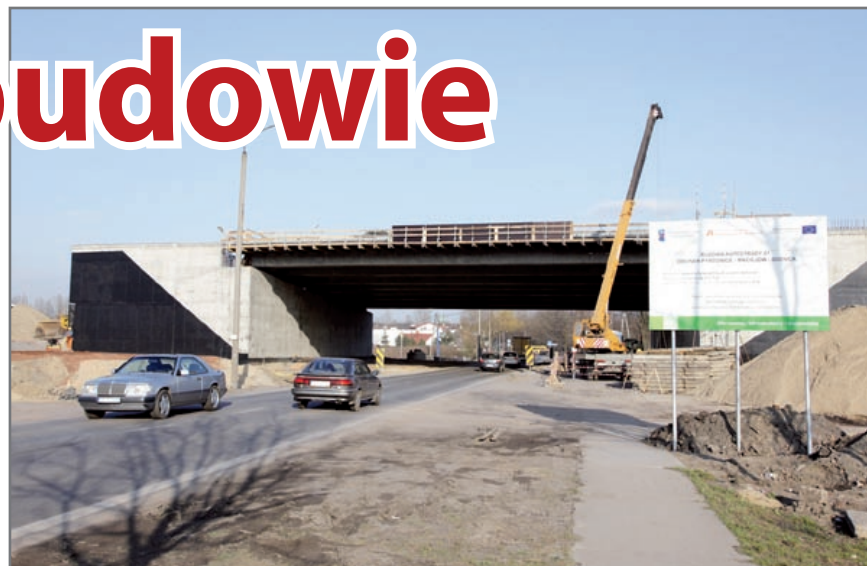
Widać już most autostradowy przy ul. Królewskiej Tamy
