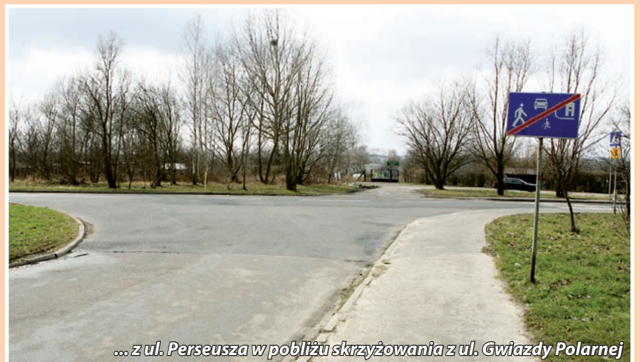
Przyszła estakada połączy ul. Portową w sąsiedztwie torów kolejowych...
