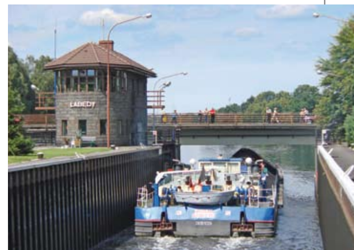
Gliwice Canal – Sluice in Labedy /Kanal Gliwice – Schleuse Labedy Kanal Gliwicki – śluza w Labędach
